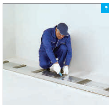
برش نوارهای عایق
