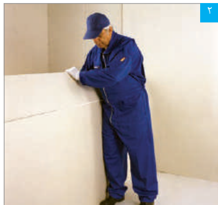
شکستن پنل در محل برش
