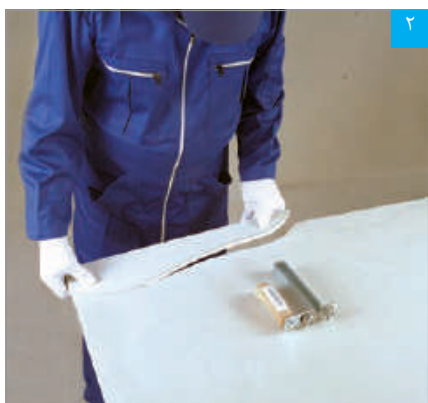
جداکردن پنل از محل برش
