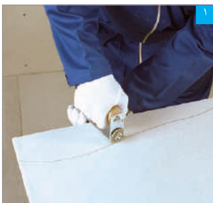
اجرای برش موج‌دار با دستگاه برش قرقره‌ای
