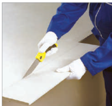
برش پنل با اره دستی
