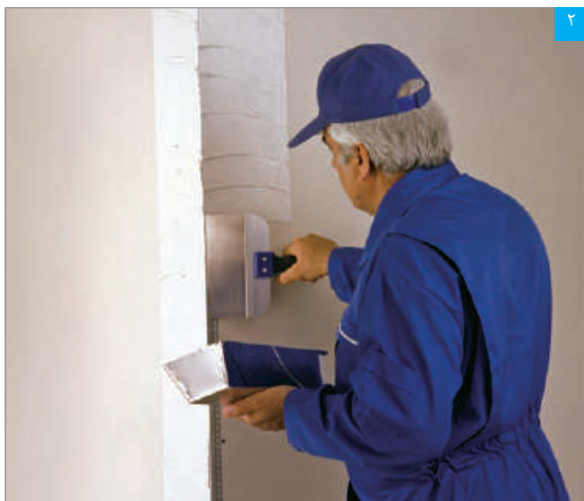
اجرای بتونه روی سازه محافظ گوشه
