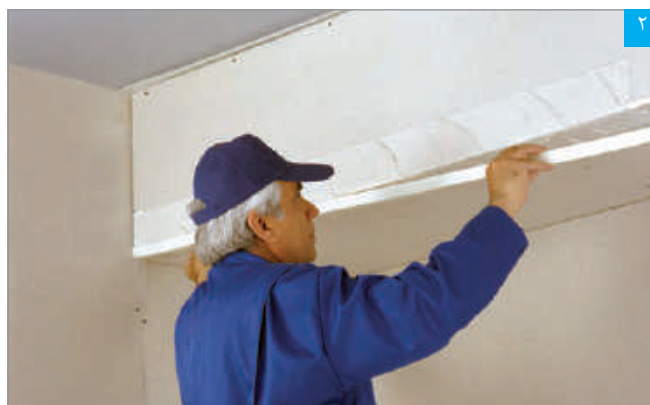
قرار دادن نوار درزگیر بر روی بتونه
