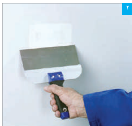
اجرای بتونه بر روی وصله ترمیمی
