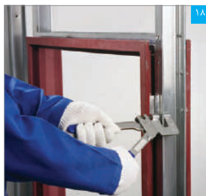
۱۸ اتصال رانر نعل درگاه به استادهای با پانچ
