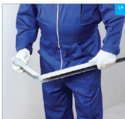
۱۶ خم کردن انتهای رانر نعل درگاه
