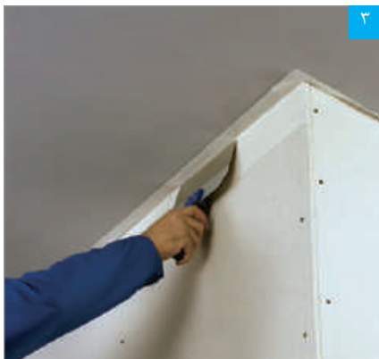
بتونه‌کاری در فصل مشترک دیوار خشک و سقف بنایی
