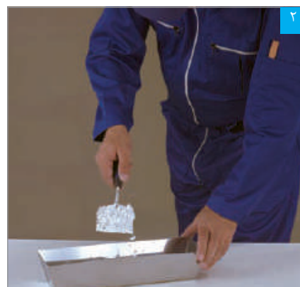
ریختن پودر بتونه در آب
