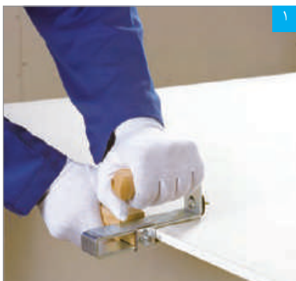
برش پنل با دستگاه برش قرقره‌ای
