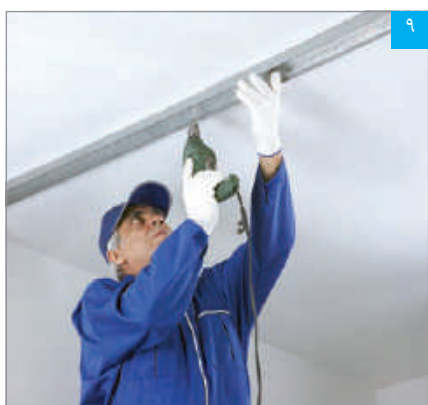
۹ نصب رانر سقف (سوراخ کردن رانر و سقف)
