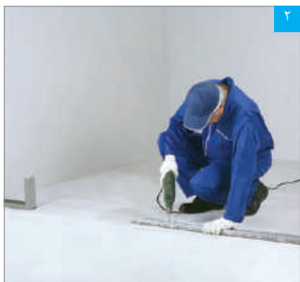
نصب رانر کف
