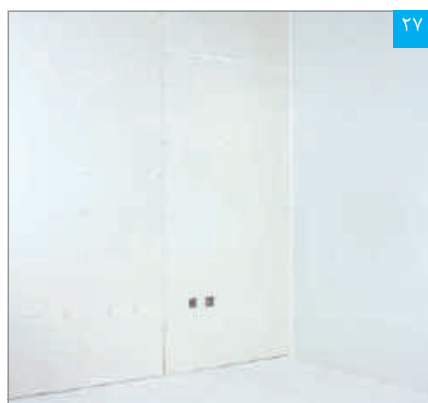
دیوار تکمیل شده (خروجی‌های تاسیساتی به وسیله گردبر یا اره چاقویی و سوهان ایجاد می‌شوند)
