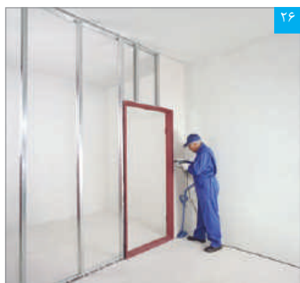
اجرای پنل اول دور چهارچوب (پنل‌ها به صورت L برش داده می‌شوند)
