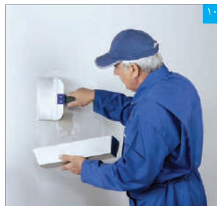
بتونه‌کاری درزها در محل ترمیم (با استفاده از نوار و بتونه درزگیر)
