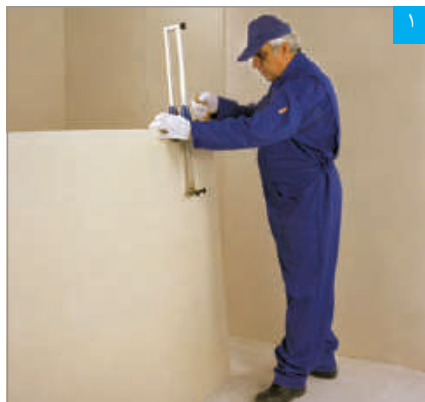
برش پنل با دستگاه برش طولی
