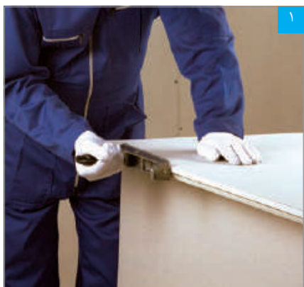
پرداخت لبه برش خورده با رنده
