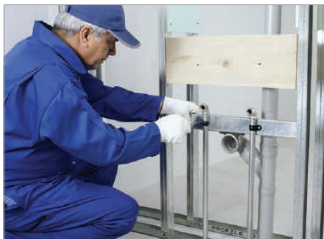
اتصال لوله‌های تاسیساتی به سازه پشتیبان SP60
