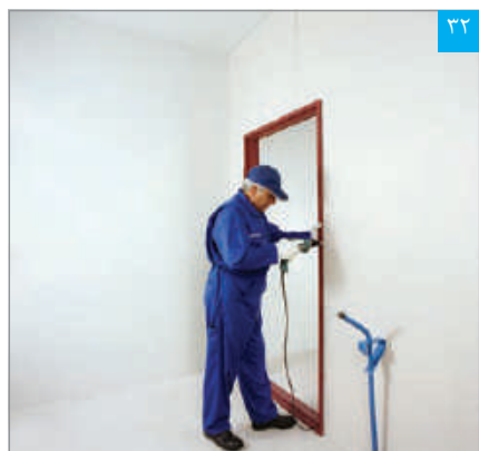
پیچ‌زنی پنل در حاشیه دور چهارچوب و تکمیل پوشش کاری
