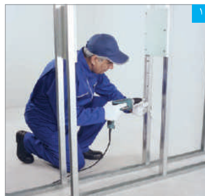
اتصال قطعات نبشی L25 به استادهای مجاور
