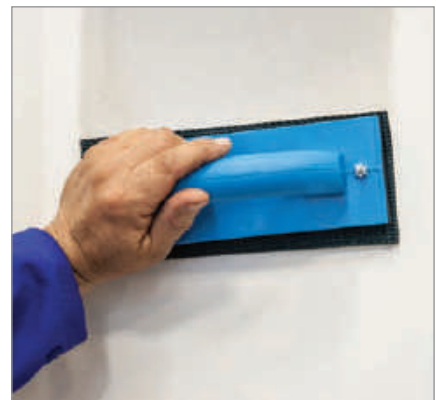
مرطوب کردن سطح دیوار با اسفنج نمدار
