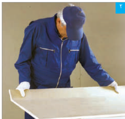
شکستن پنل در محل برش
