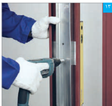
۱۳ چهارچوب توسط پیچ LB در محل صفحات نصب به استادهای متصل می شود
