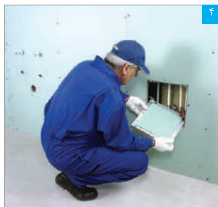
قرار دادن پنل دریچه در درون قاب
