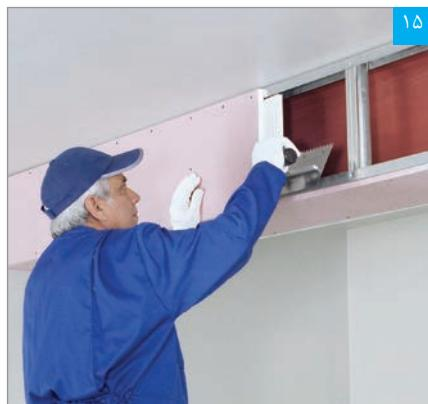
اجرای بتنه درزگیر بر روی نیمه دیگر پنل پشت بند درز (پس از خشک شدن بتنه درزگیر نیمه اول)
